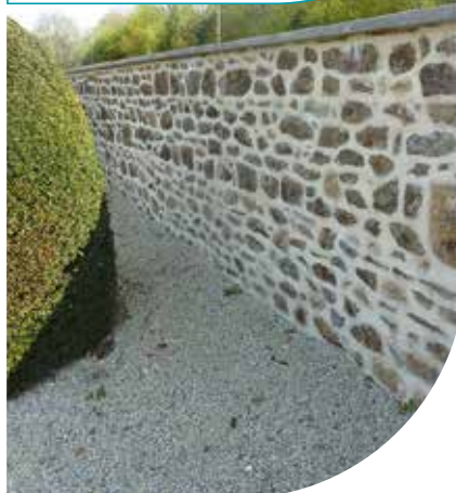
Le mur d'enceinte restauré.
