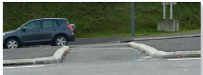
Parallèlement aux travaux de réfection d'enrobés effectués par la DIR Ouest sur la rocade, une traversée piétonne a été aménagée au giratoire de La Pilais. Une zone refuge centrale a été créée afin de pouvoir traverser en deux temps. Par contre, il n'y a pas de marquage au sol car le ronds-points est situé hors agglomération. En accord avec la DIR Ouest, le Conseil municipal a confié les travaux à l'entreprise COLAS, pour un montant de 27 785, 40 € TTC.
